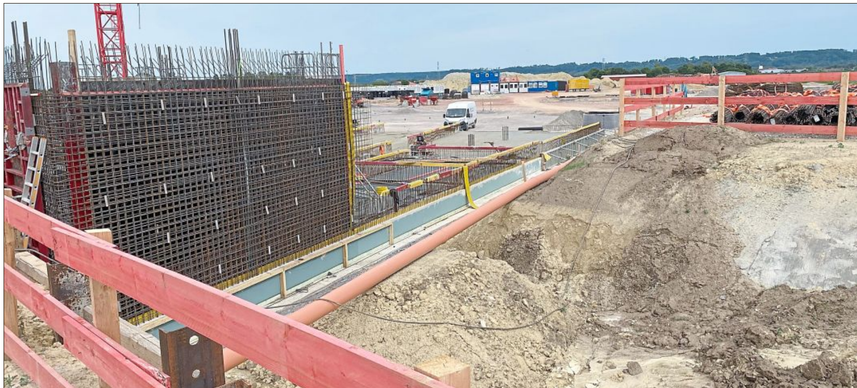
Aktuell wird an dem Flügelteil des Landratsamts betoniert, in den auch der Eisspeicher hineinkommt. Mehr Fotos zur Baustelle auf idowa plus. Fotos: Stefanie Wieser
