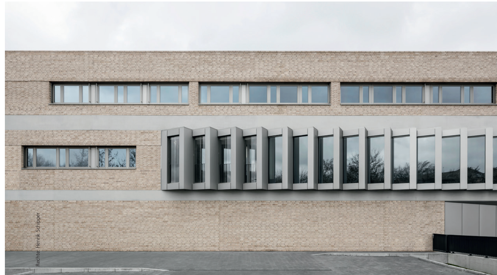
» View from the north with zigzag facade » Ansicht Nord mit Zickzackfassade
