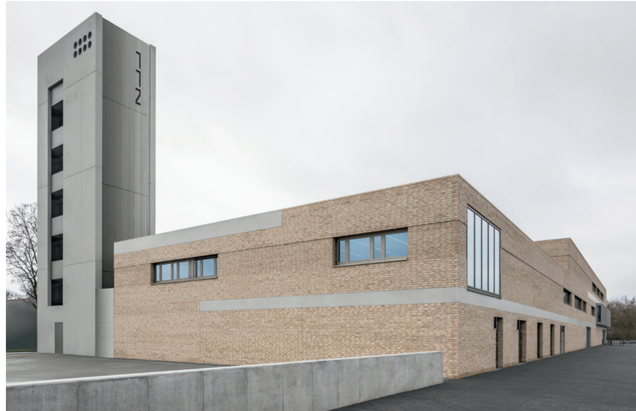
» Northeast view with hose tower » Ansicht Nordost mit Schlauchturm
